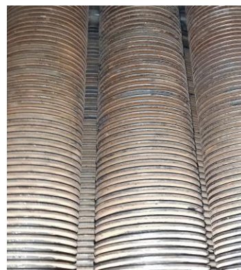
Рисунок 1. Внешний вид поверхностей теплообменника
